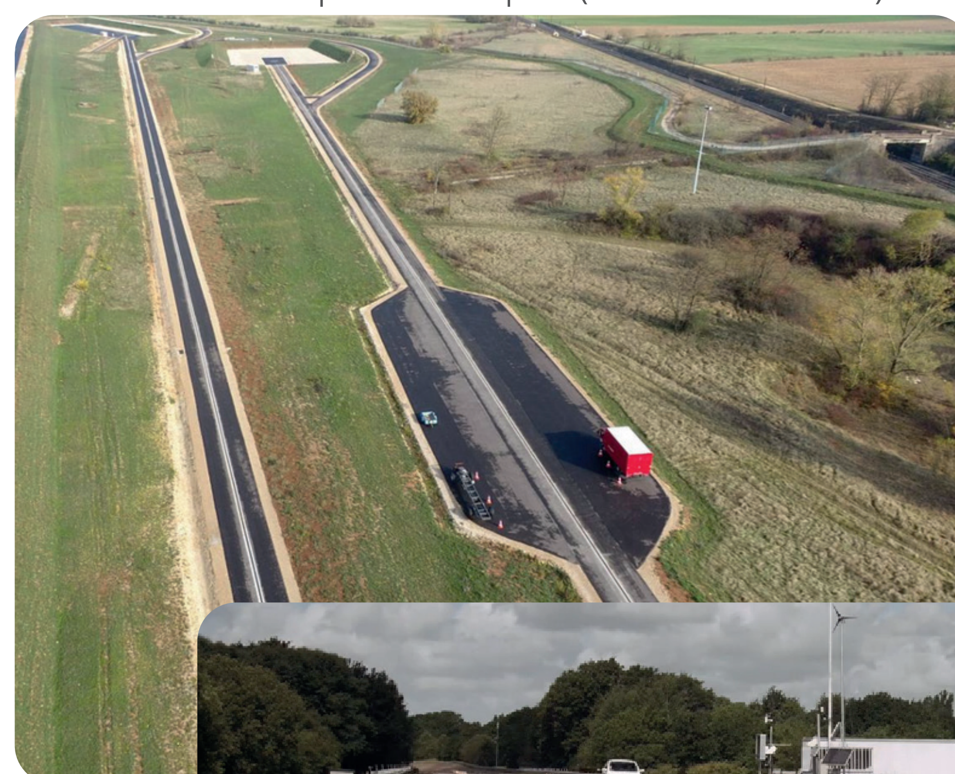
Piste d'essais acoustiques de Transpolis (site des Fromentaux)
